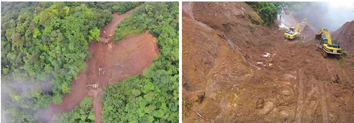
Deslizamiento ocurrido en julio 2015
