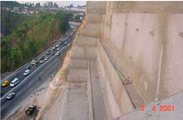
Ejemplos de muros anclados en obras viales
