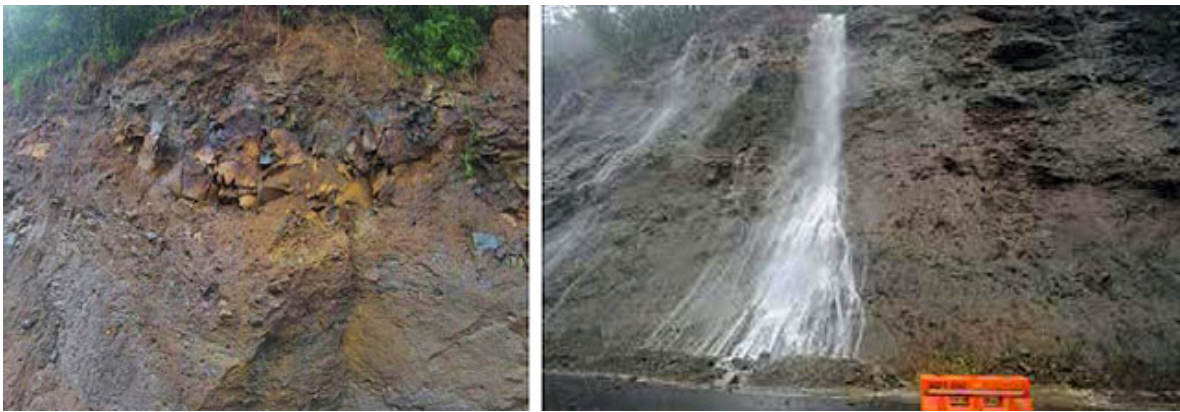
Taludes rocosos muy fracturados con ausencia de obras de drenaje pluvial
