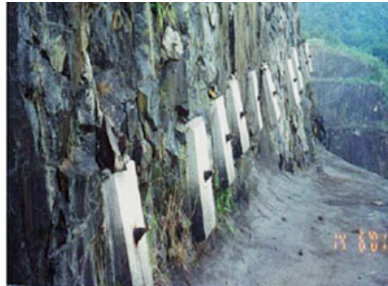
Ejemplos de muros anclados en obras viales
