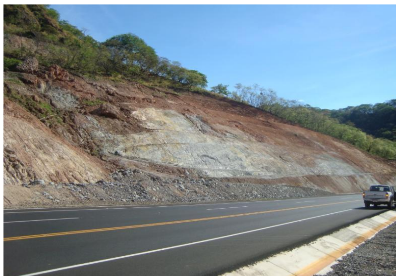
Grandes bloques de roca con condiciones precarias de estabilidad en un sector de la carretera, ubicado a unos trescientos de metros después de la zona donde se construye el viaducto para el ferrocarril. Nótese el efecto del hidrotermalismo en los taludes y bermas.
