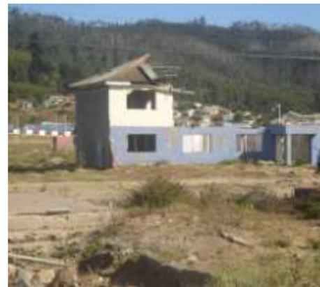
*Vivienda afectada por el tsunami en la ciudad de Dichato, donde la altura de las olas generadas por el tsunami alcanzó los techos de viviendas de dos niveles.*
